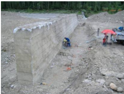
Figura 3 - Taglio di una briglia all'altezza definita nel progetto mediante sega a punti di diamanti. (Foto: Prov. Aut. Bolzano)
