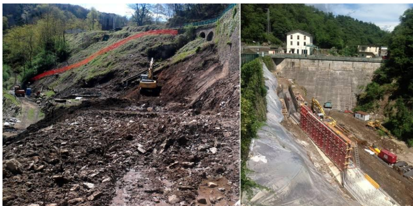
Figura 3 – Cantiere di costruzione del passaggio per pesci presso la diga di Creva sul Fiume Tresa (2012, Foto: GRAIA s.r.l.).
