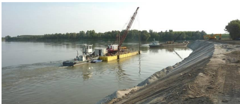
Figura 6 - Lavori di realizzazione della difesa di sponda (Foto: F. Filippi).
