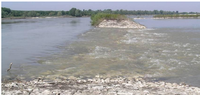
Figura 7 - Pennello abbassato, in fase di tracimazione, visto dalla sommità verso monte. A sinistra della foto l'alveo principale del fiume Po, a destra il ramo secondario riattivato (Foto: F. Filippi).
