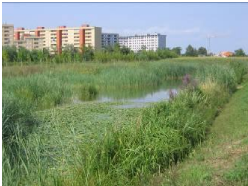
Figura 7 – Zona umida in alveo creata ampliando la sezione del canale e diversificando opportunamente i profili longitudinali e trasversali (Foto: Cons. Bon. Acque Risorgive – VE).
