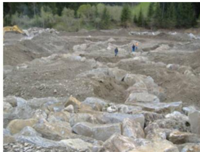
Figura 4 - Costruzione di una rampa in massi sciolti, che dopo il compimento, è stata coperta con sedimenti dell'alveo. (Foto: Prov. Aut. Bolzano)
