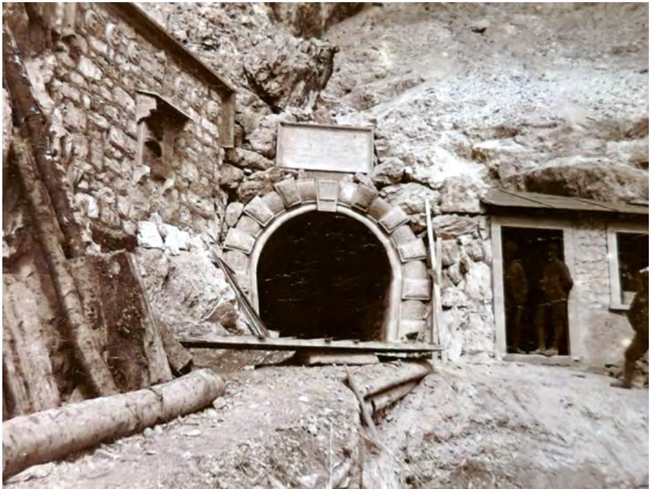
**16** Das aufwendig gestaltete Südportal des Paternkofelstollens 1917. Links an der Stützmauer die Büste des italienischen Königs, darüber die Wappen der am Bau beteiligten Einheiten. Rechts ein Unterstand.
