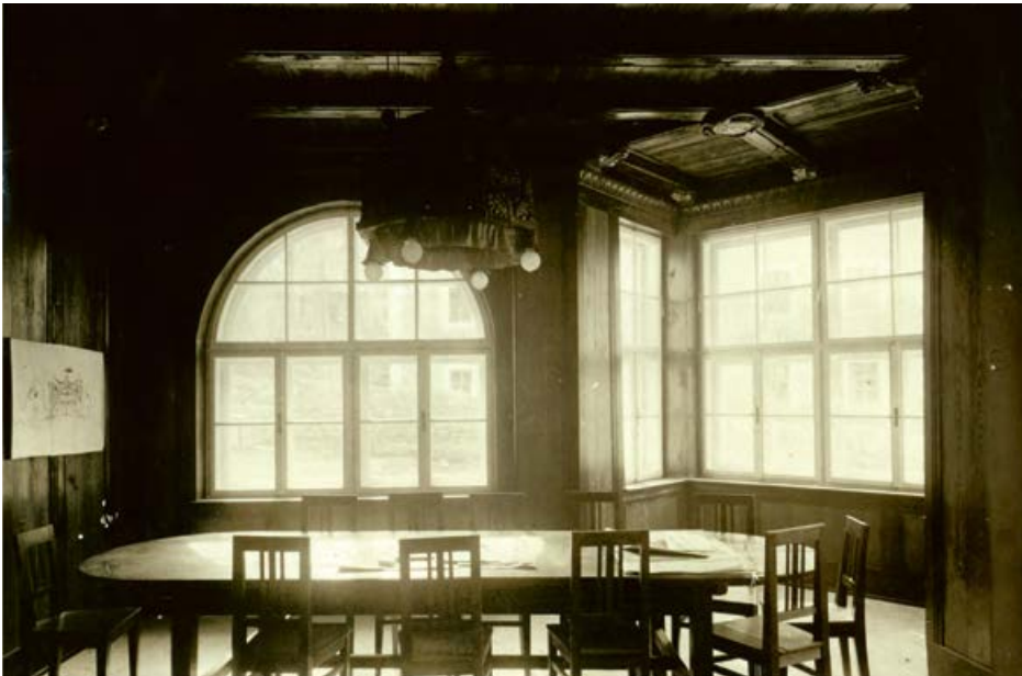
6 Beratungszimmer des Bürgermeisters im Erkerraum des Rathauses von Sexten nach Entwürfen von Clemens Holzmeister, 1923. Unbekannter Fotograf. Aus: Museo Centrale del Risorgimento, Rom, Album T16. © MCCR. Abbildung mit Genehmigung.
