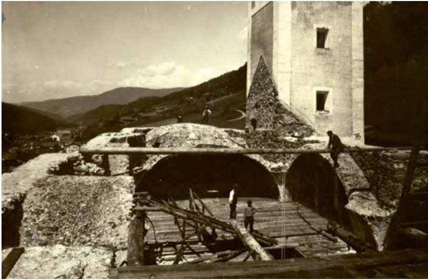
15 Pfarrkirche St. Veit während der Einwölbung, 1921. Unbekannter Fotograf. Aus: Museo Centrale del Risorgimento, Rom, Album T42. © MCRR. Abbildung mit Genehmigung.
