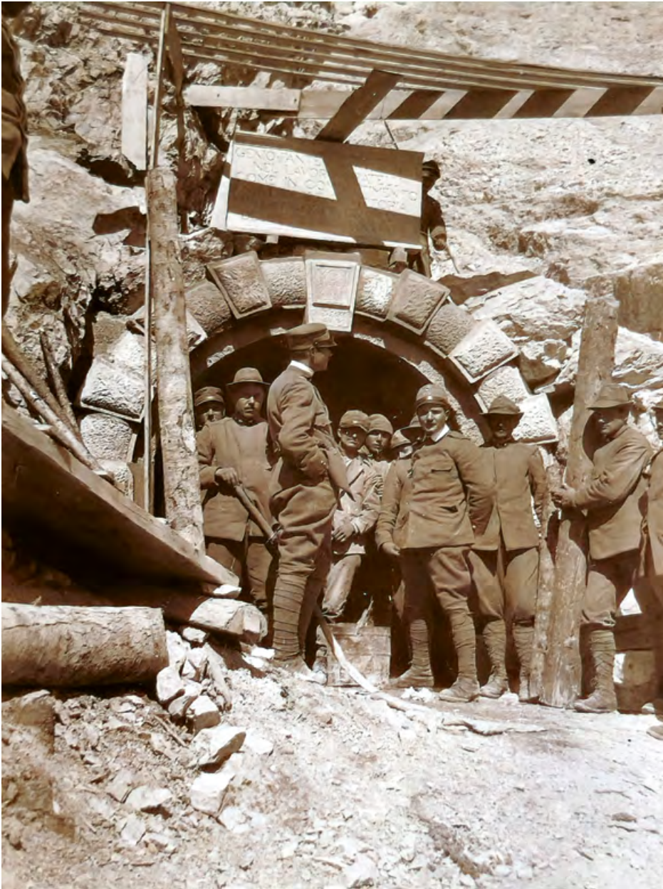
15 Versammelte Offiziere und Mannschaften vor dem Südportal des Paternkofelstollens während der Bauarbeiten 1917. Aus: Privatarchiv Lt. Enrico Gualtiero. © Enrico Gualtiero. Abdruck mit Genehmigung.
