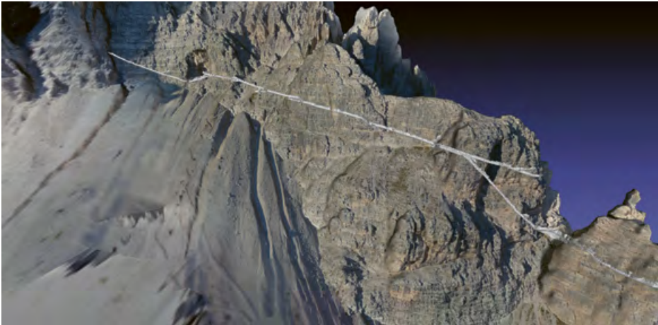
5 Der Stollen im 3D Modell, Ansicht von Norden. © 2021, unibz, WiL Archive. Abdruck mit Genehmigung.
